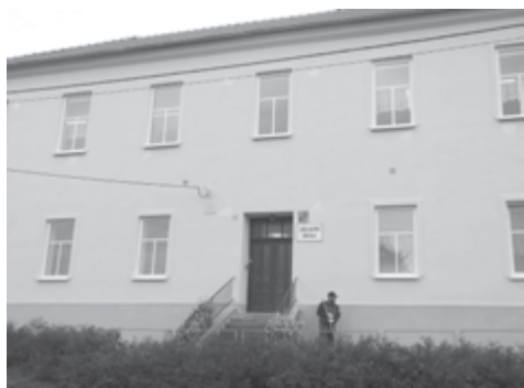
1. září – rekonstrukce se podařila v termínu
