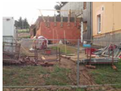
30. červen – přístavba kuchyně
