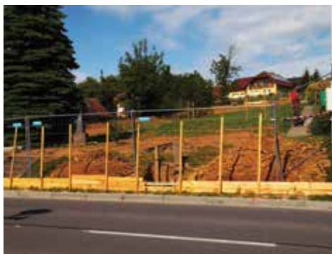
Konec května – začátek rekonstrukce
